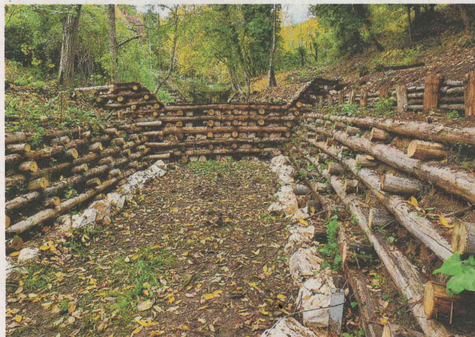
Ingegneria naturalistica per la difesa del suolo e per la prevenzione delle alluvioni: Palificate vive e briglie in legname pietrame nel Torrente Jana - Comune di San Marco in Lamis.
