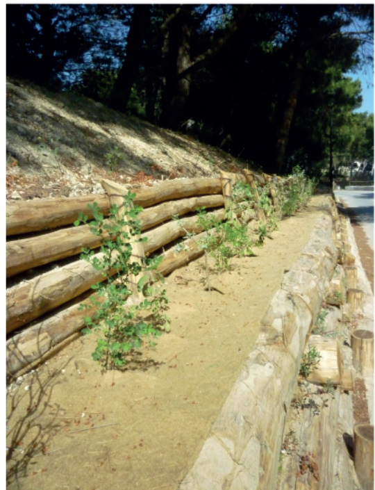
Consolidamento di scarpata stradale con palificate e palizzate Isole Tremiti
