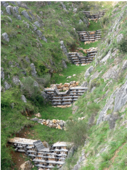
Sistemazione idraulico-forestale con briglie in legname e pietrame San Marco in Lamis
