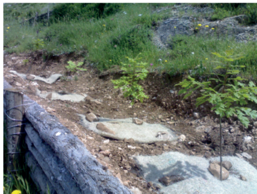
Rimboschimenti con specie autoctone su gradoncini realizzati con palizzate – San Marco in Lamis
