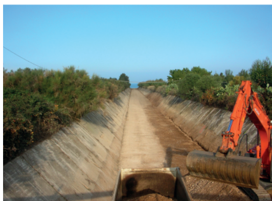
Interventi di manutenzione torrente Macchio – Vieste
