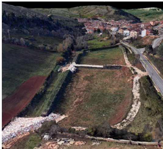
Vasche di laminazione realizzate con tecniche di Ingegneria naturalistica (terre armate rinverdite) – San Marco in Lamis
