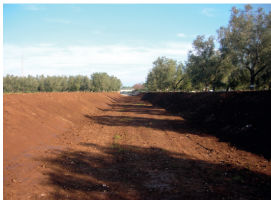
Interventi di manutenzione torrente La Teglia – Vieste
