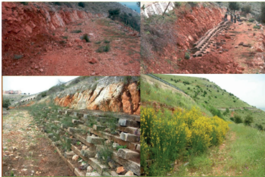
Palificata viva a doppia parete (ante, durante e post lavori) Rignano Garganico
