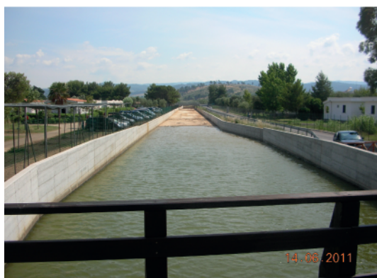
Interventi di sistemazione idraulica torrente La Teglia – Vieste
