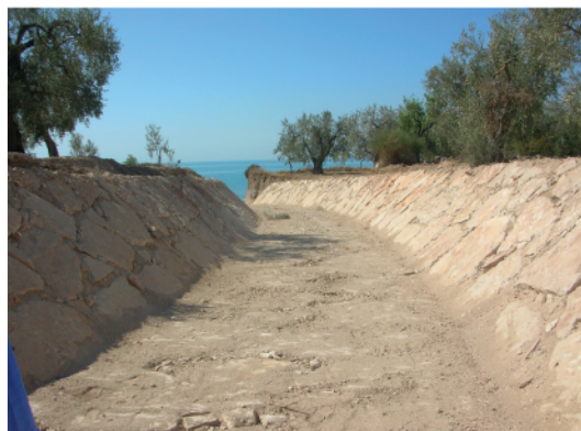
Interventi di sistemazione idraulica torrente Stamporlando Monte Sant'Angelo
