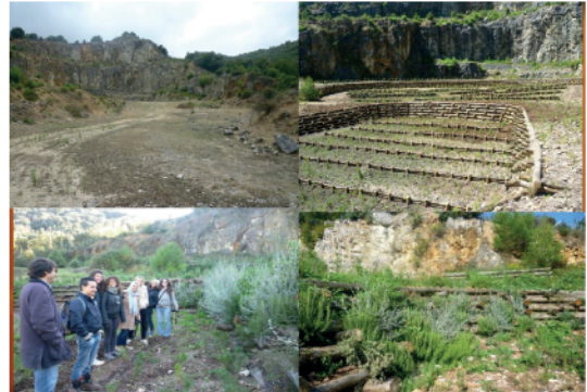
Ripristino ambientale di cava dismessa con tecniche di ingegneria naturalistica - Vieste
