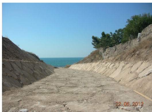
Interventi di sistemazione idraulica torrente Varcaro Monte Sant'Angelo
