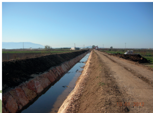
Interventi di mitigazione idraulica torrente Santa Barbara – Ischitella
