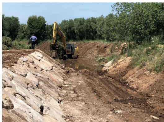
Interventi di manutenzione torrente Antonino – Carpino
